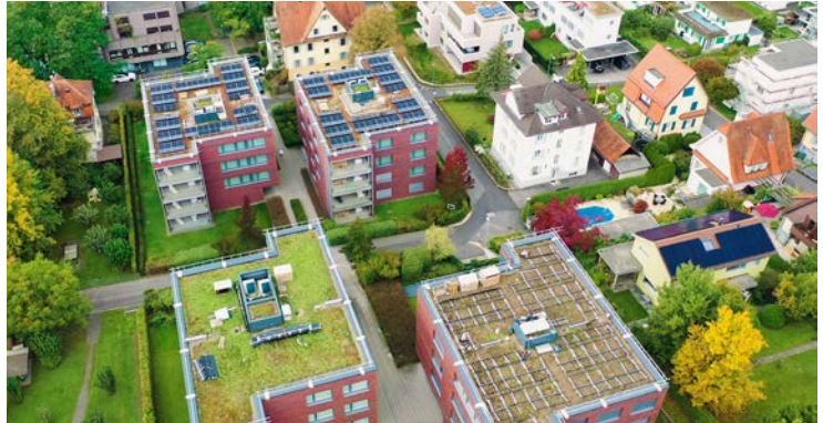
Herbst 2022: Montage von über 370 Solarmodulen auf den Dächern des Haldenhofs im Zentrum von Zug.
