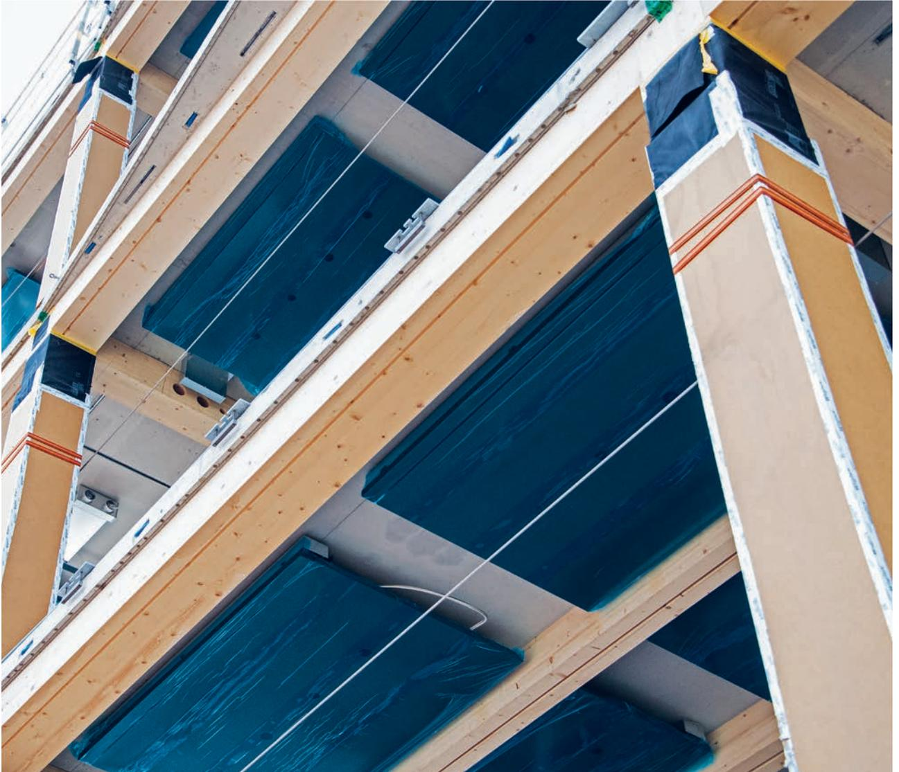
Das mittlerweile fertiggestellte Holzhochhaus Arbo wurde in Holz-Hybrid-Bauweise erstellt.
