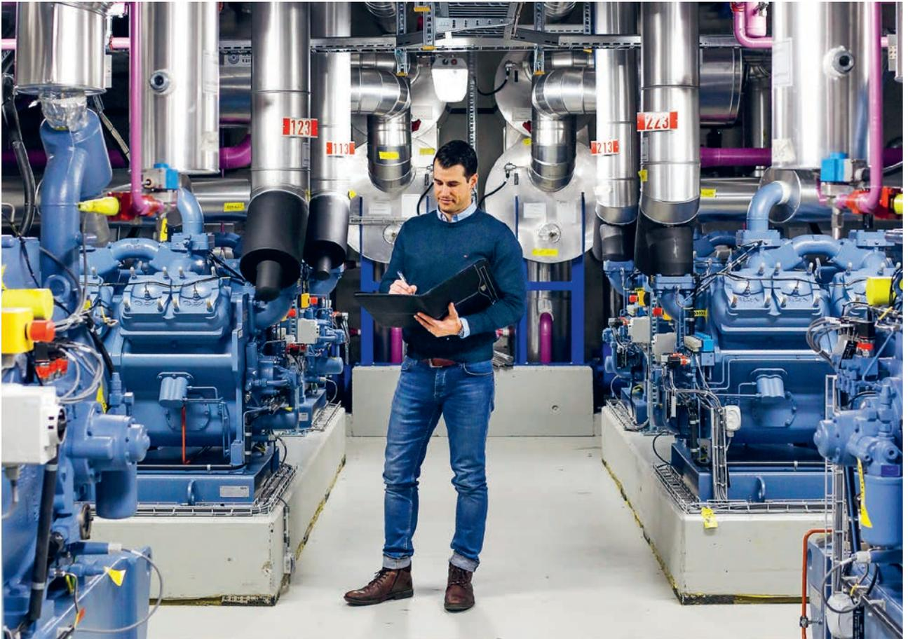
Wärmepumpen in der Energiezentrale der WWZ im 3. UG der Metalli.
